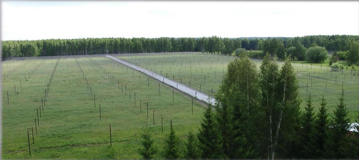
Радиотелескоп меридианного типа БСА ФИАН был создан в 1970 – 1974 г.г. и представляет собой эквидистантную фазированную антенную решетку, состоящую из 16384 волновых диполей расположенных на площадке 200x400 м. Радиотелескоп первоначально работал в диапазоне 101 - 104 МГц, в 90 годы был перенастроен на диапазон 109 – 113 МГц.
