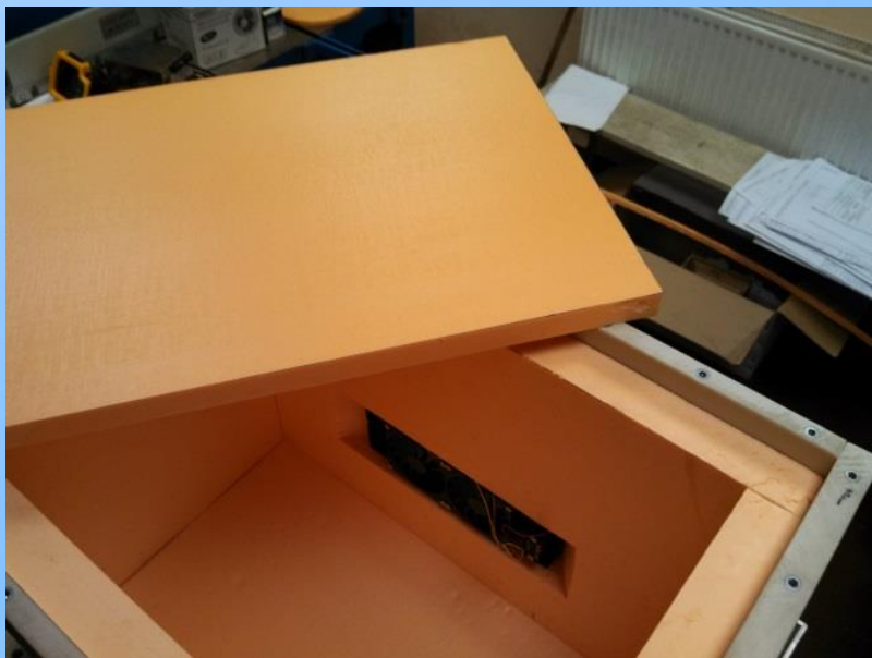
Теплоизоляция контейнера: Пенополиуретан(ППУ)
